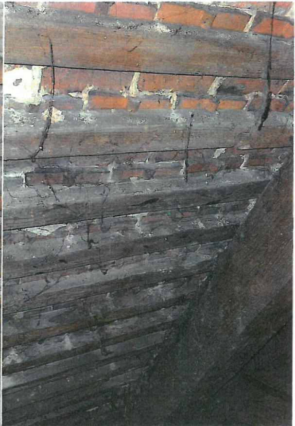
Zdj. 17 Widoczne zacieki na zaprawie na łatach
