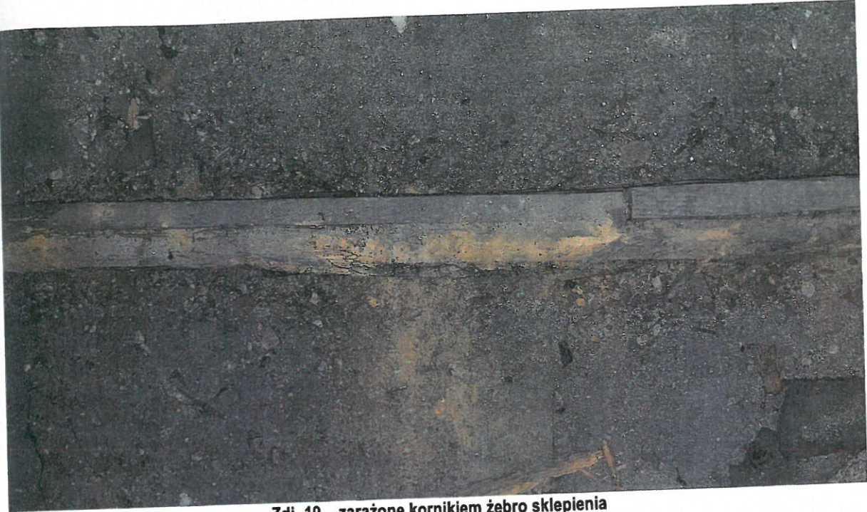
Zdj. 19 – zarażone kornikiem żebro sklepienia
