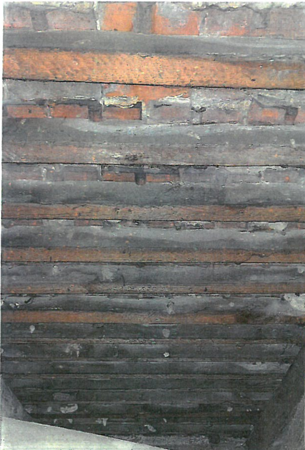
Zdj. 17 Widoczne zacieki na zaprawie na łatach
