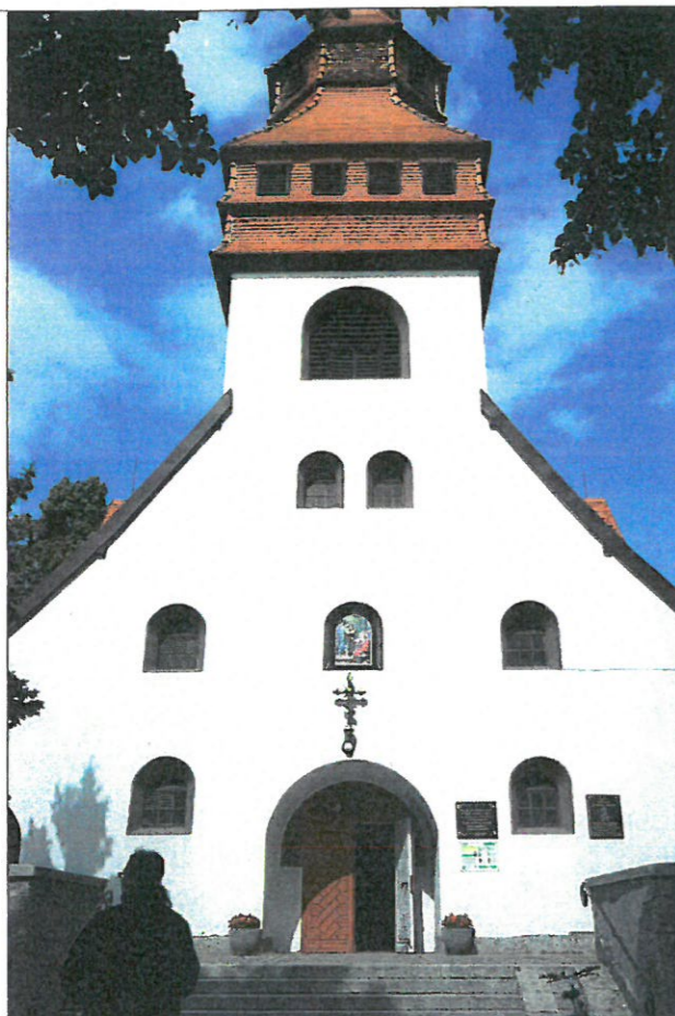
zdjęcie 1. elewacja południowa, wejściowa, z wieżą kościelną widoczne wiatrownice z blachy przeznaczone do rozbiórki
